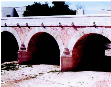
Los tres ojos del puente.
