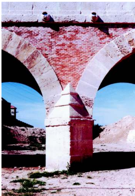
Uno de los tajamares triangulares de sillería que sustentan el puente.
