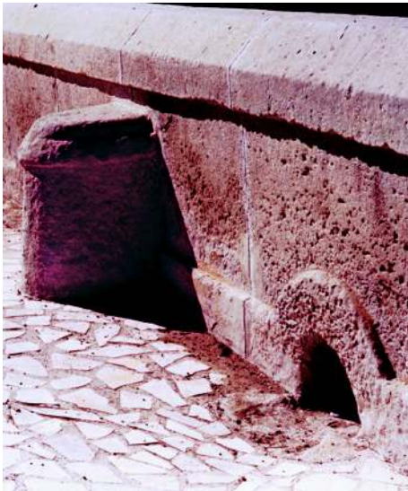
Detalle del puente: imposta de sillería con gárgola de desagüe, pretil y nuevo pavimento.
