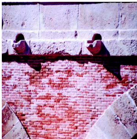
Detalle del puente: imposta con gárgolas, fábrica de sillería y ladrillo.
