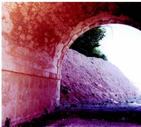
Bóveda del puente de sillería y contrafuerte de mampostería.
