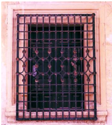
Ventana y reja del palacio del Marqués de Montortal.
