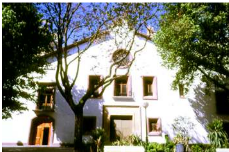
Fachada de la iglesia de Santiago
