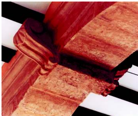
Detalle del techo de la planta baja: ménsula central en el arco de acceso desde el zaguán al patio.
