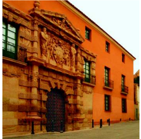
Fachada principal de la Casa Grande
